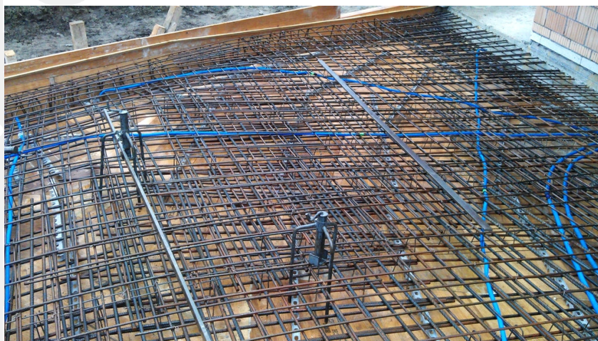
Rampendecke mit bauseitiger Anpassung der Bewehrungen an vorhandenen Radius
